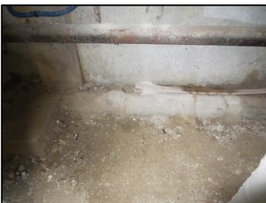
Photo N° 708 AMIANTE CIMENT 18 BLAISE-S.sol-COULOIRS DE CAVES Conduits de fluide Chute E.U.(Fibres-ciment)
